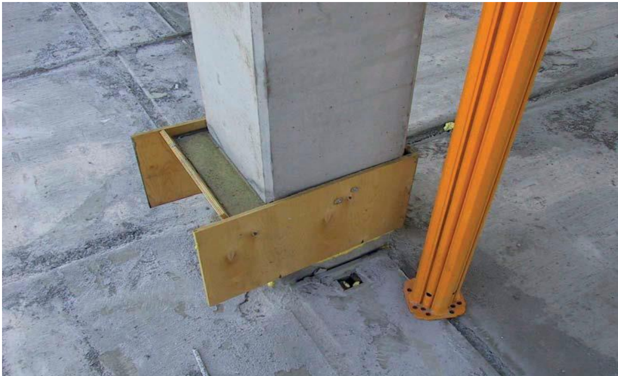
Pilt 12. Konstruksioonelemendi monolitiseerimisel kasutatav raketis
